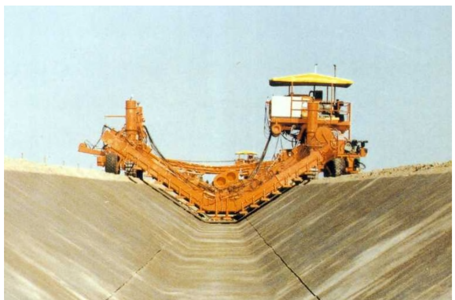
Gleitschalungsfertiger. Für trapezförmige Kanäle und Böschungen.
