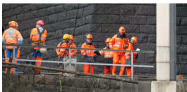
Die Gleise müssen freigelegt werden
