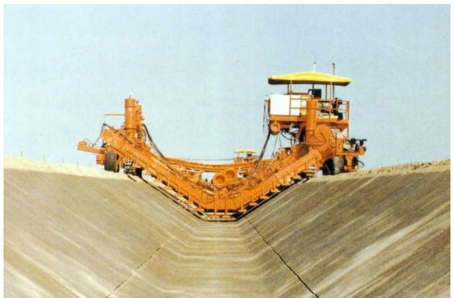
Gleitschalungsfertiger. Für trapezförmige Kanäle und Böschungen.
